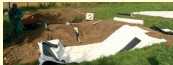
Vzpostavlanje vzorčne rastlinske čistilne naprave Setting up a model plant-based purification system
